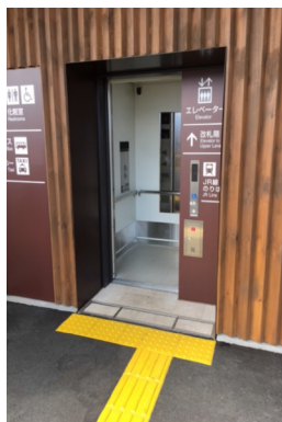
JR小淵沢駅に新設されたエレベーター
