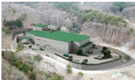
▲建設中の諏訪南リサイクルセンター (完成予想図)
