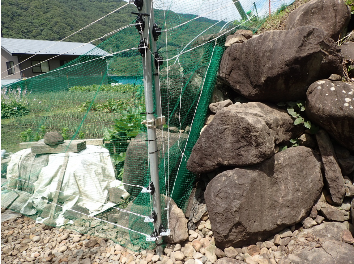
最終的に段差が大きい部分には、単管パイプを支柱に活用した。
