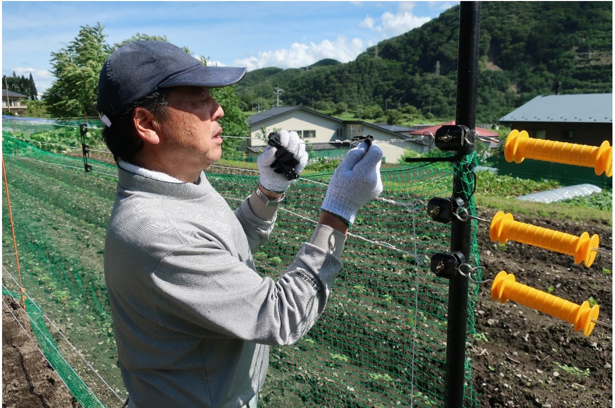
柵線にテンションをかけ、緩まないように緊張具をゲート脇に取り付ける。
