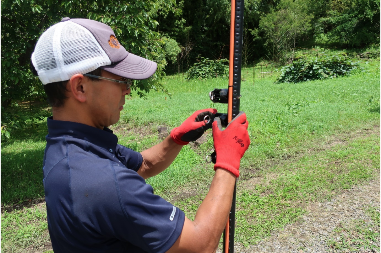
ポールに目印を書き込み、それを目当てに碍子を取り付ける。
