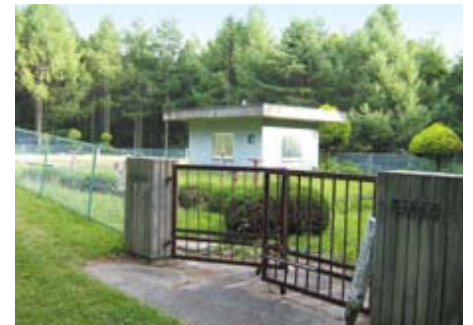
八ヶ岳第5配水池
