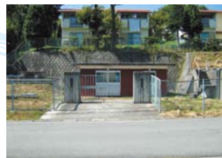
神戸ポンプ場
