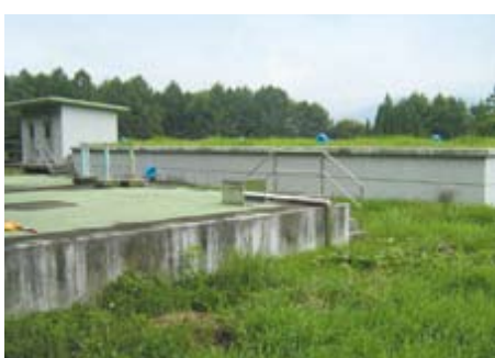
第9水源配水池
