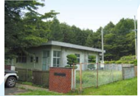
八ヶ岳第1配水池
