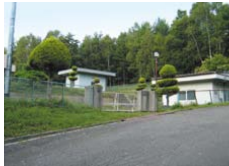
八ヶ岳第4配水池
