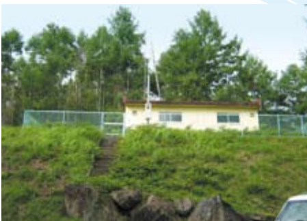
ふれあいの郷配水池
