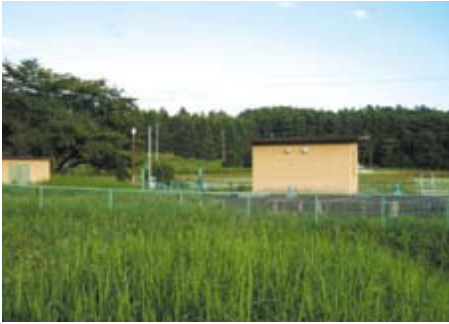
葛窪第1配水池
