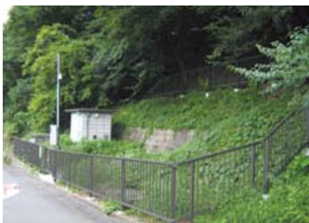
下蔦木配水池
