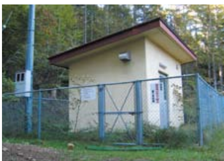
池の十第2ポンプ場
