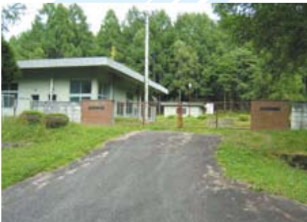
八ヶ岳第2配水池
