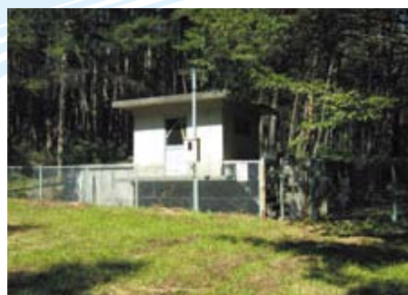
神戸第2配水池
