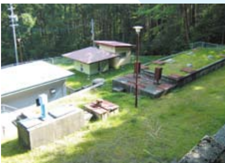
池の十浄水場
