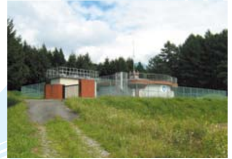
大婦奈配水池
