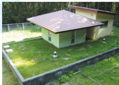
池の十浄水場
