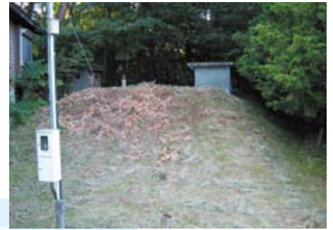
西久保配水池
