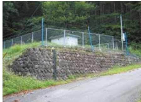
上蔦木第1配水池
