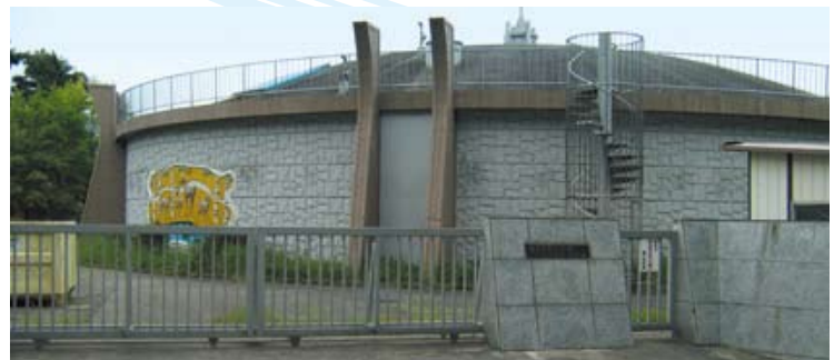
富士見第3配水池
