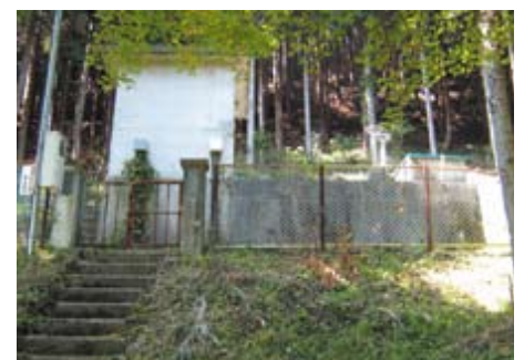
レジャーセンター配水池
