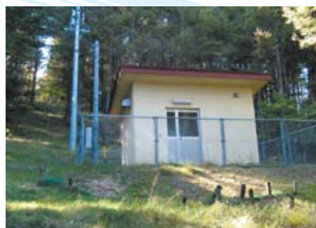
池の十第3ポンプ場
