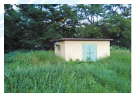
東三区配水池
