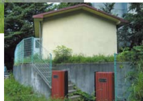
中丸沢ポンプ場
