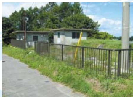
乙事低区配水池
