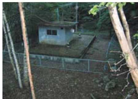
青木の森高区配水池
