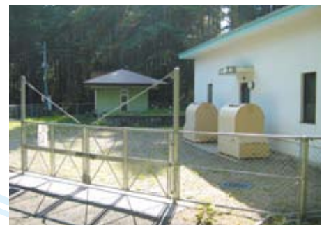
池の十浄水場
