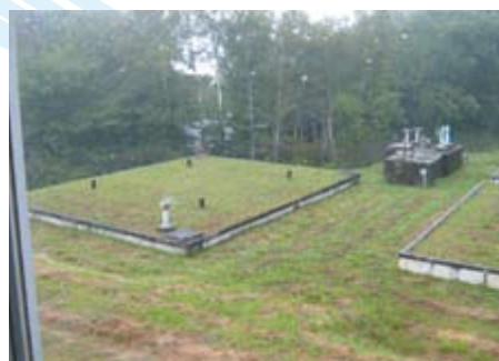
富士見第1配水池
