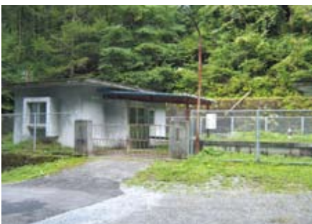
青木の森低区配水池
