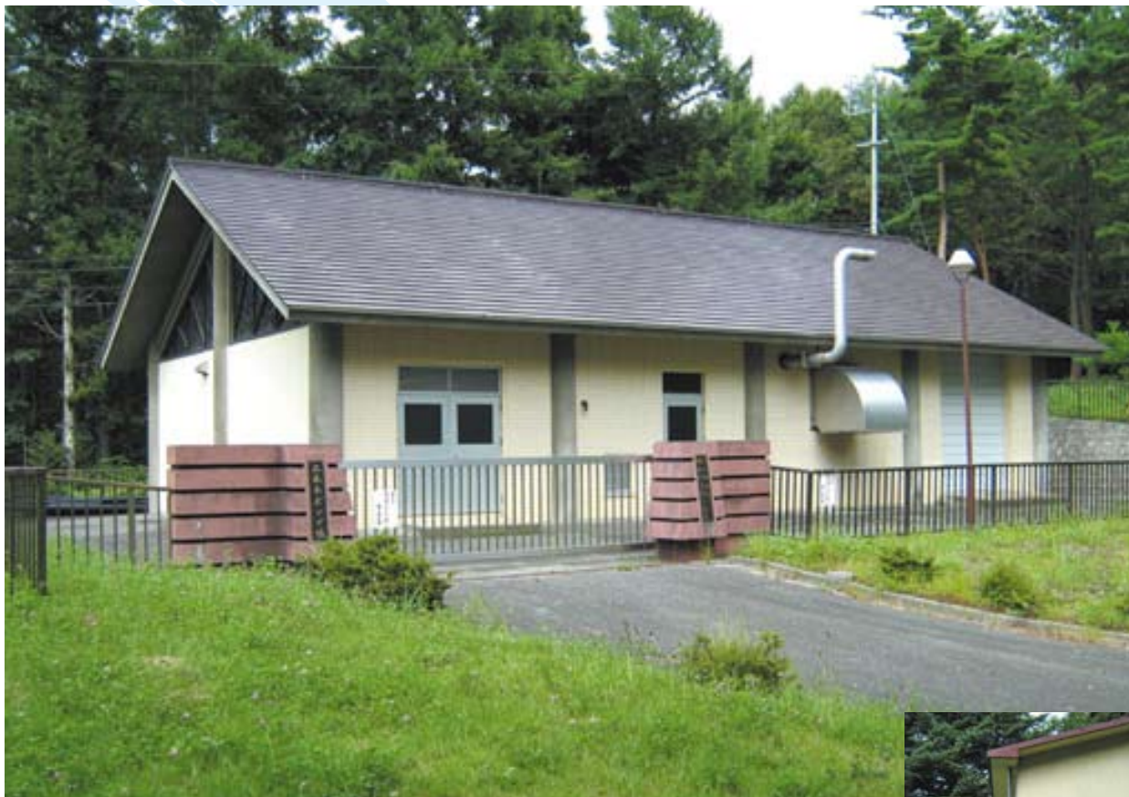
二本木ポンプ場
