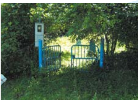
神戸第1配水池
