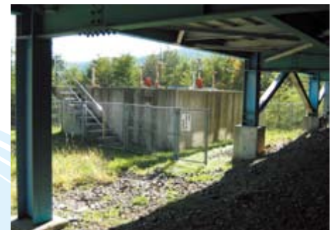
池の十高区配水池
