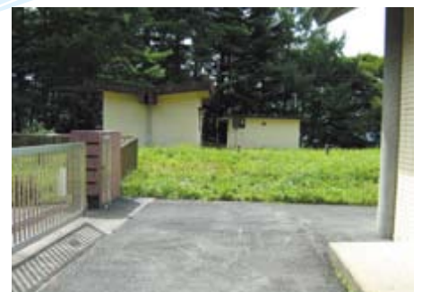
乙事高区配水池
