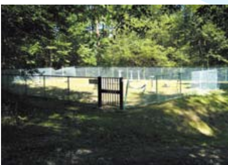
パノラマスキー場配水池
