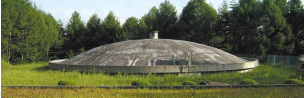
八ヶ岳第3配水池
