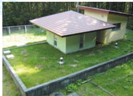
池の十配水池
