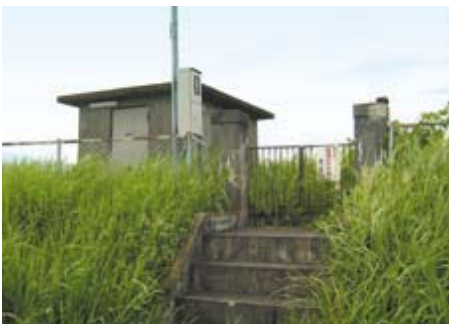
新田原配水池
