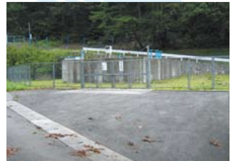
上蔦木第2配水池
