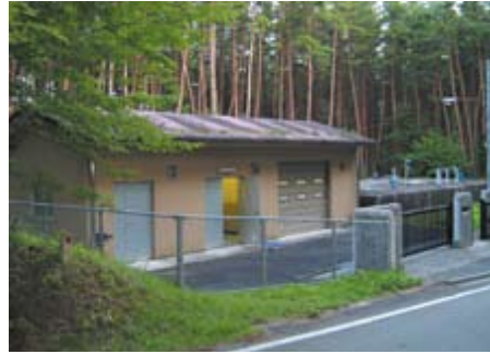
葛窪第2配水池
