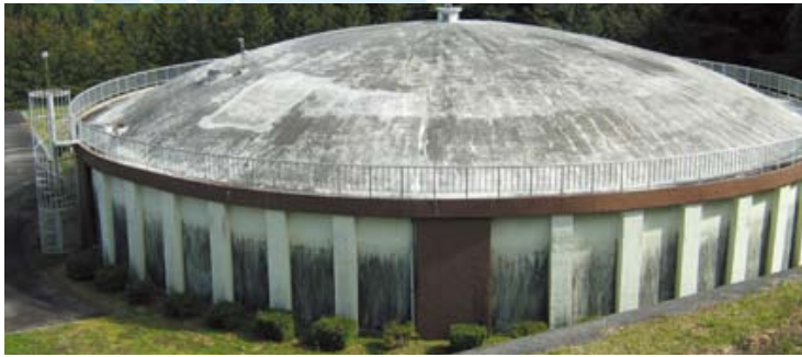
富士見第2配水池
