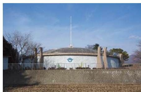
富士見第3配水池
