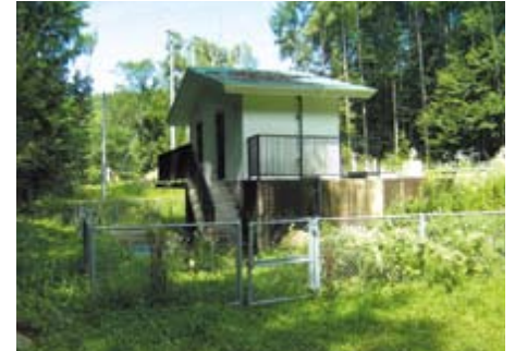
焼茅野配水池
