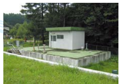
梨木原住宅団地配水池
