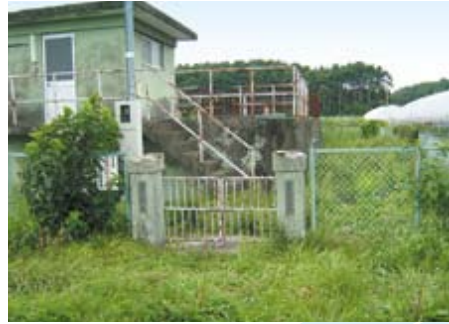
南原山配水池
