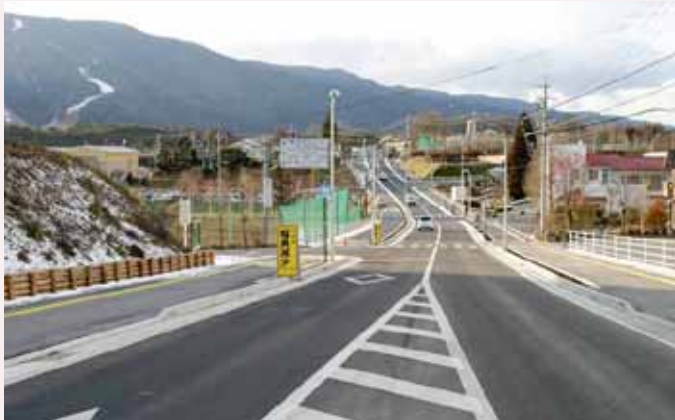
都市計画道路 「北通り線」竣工
