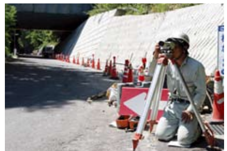
瀬沢新田 町道3672号線 舗装工事現場にて
