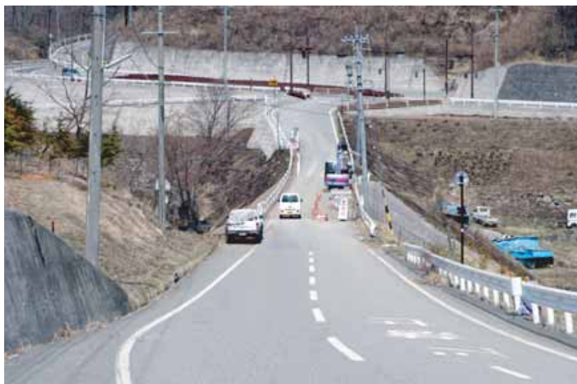
町道西山環状線小手沢付近 道路改良工事
