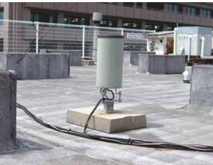
消防署に設置されている雨量計
