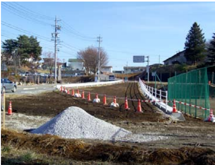
工事に着手した「富士見駅北通り線」
