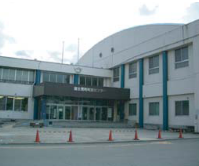
総合的に勘案し、耐震化が検討されている町民センター
