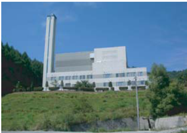
町の可燃ごみが焼却処理されている 諏訪南清掃センター
