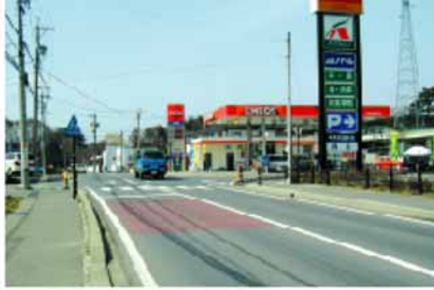
道路改良が求められるあぐりモール入口
