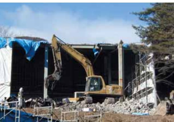
取り壊し中の焼却炉 (南諏衛生センター)
