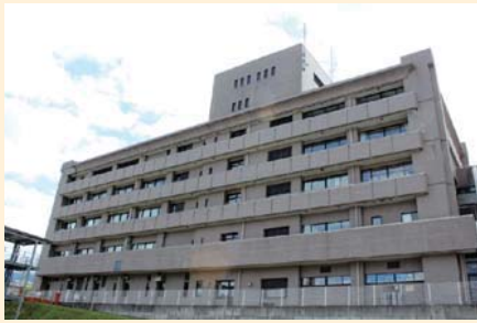
▲役場庁舎(北側より)
