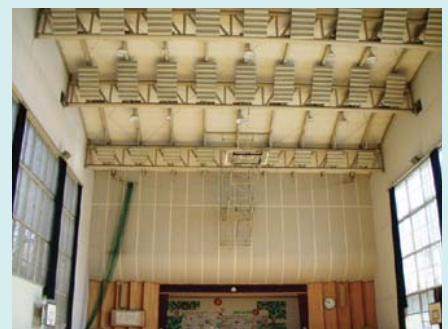
▲体育館天井の様子
