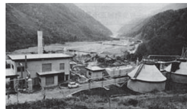
▲南諏衛生センター完成
