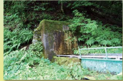
白谷程久保隧道
