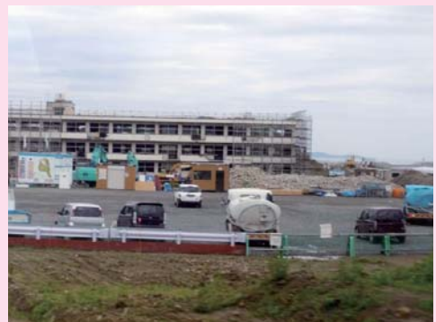
被災した豊間中学校の解体現場
