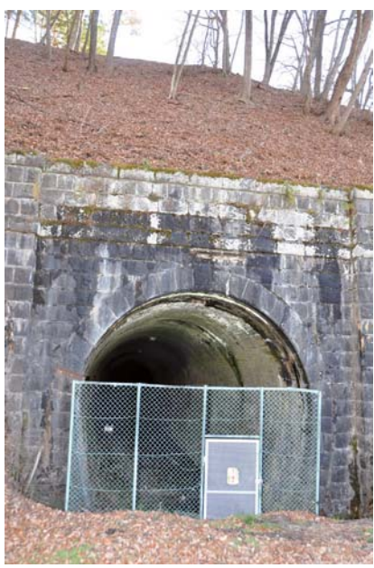
旧国鉄のトンネル
