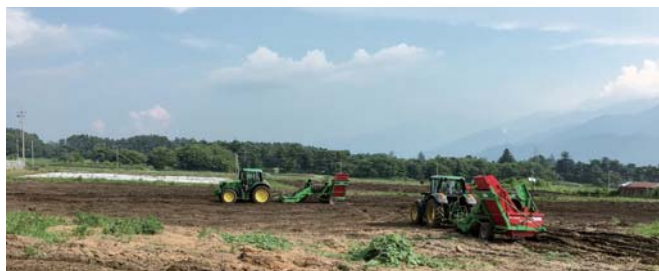
乙事地区でトップリバーが進める畑除礫作業
