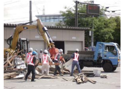
道路復旧作業
