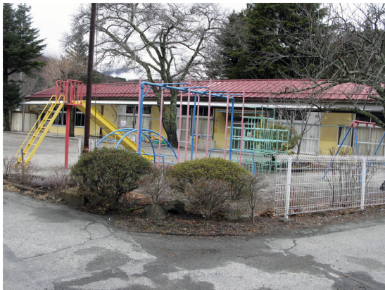
改修工事を行う落合保育園の園舎
