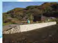
擁壁、石積工事
