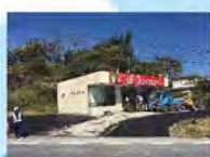
駐車場・フェンス 舗装工事
