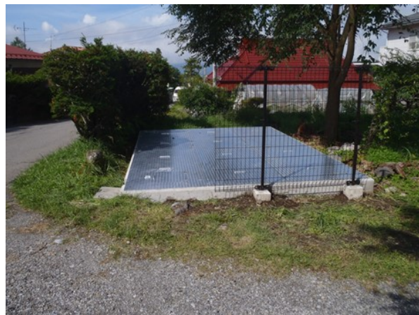
立沢区防火貯水槽上蓋設置工事
