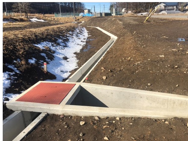
完成した用水路工事
