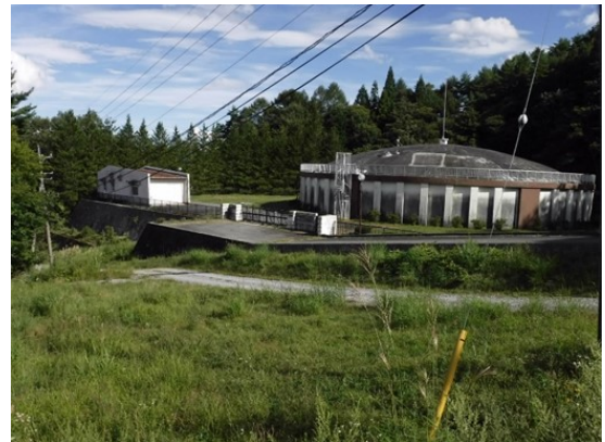
富士見第2配水池
