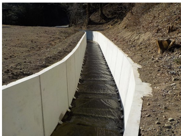
平成30年度の工事箇所
