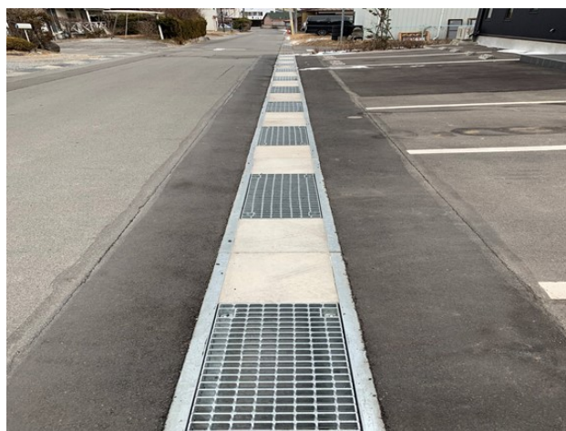
完成した道路側溝改修工事
