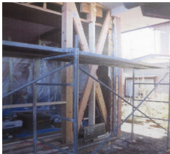
筋交い補強による耐震化工事
