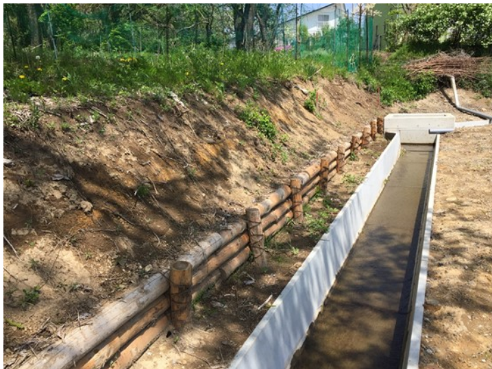
完成した用水路と土留め工
