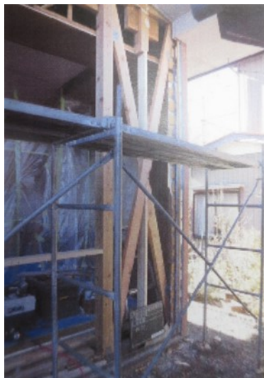
筋交い補強による耐震化工事
