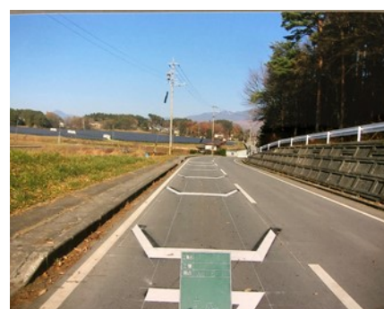
【減速マーク施工後】
