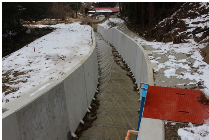
平成29年度の工事箇所
