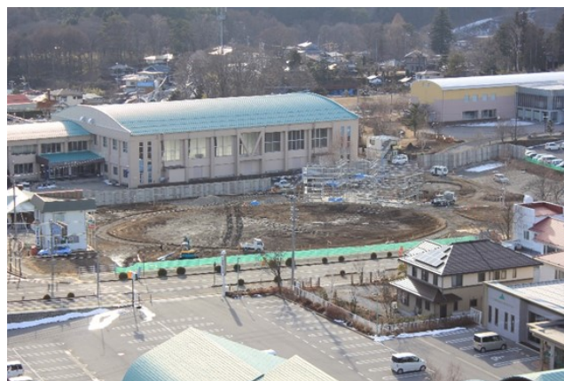
多目的交流広場仮称「ゆめの森」建設風景
