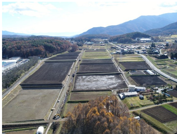
水田汎用化・大区画化の工事
