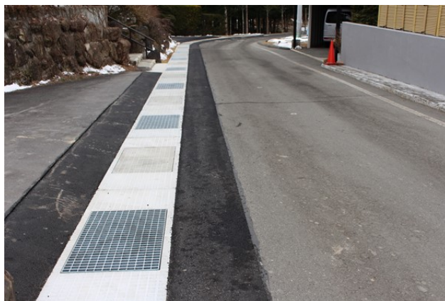
完成した道路側溝改修工事
