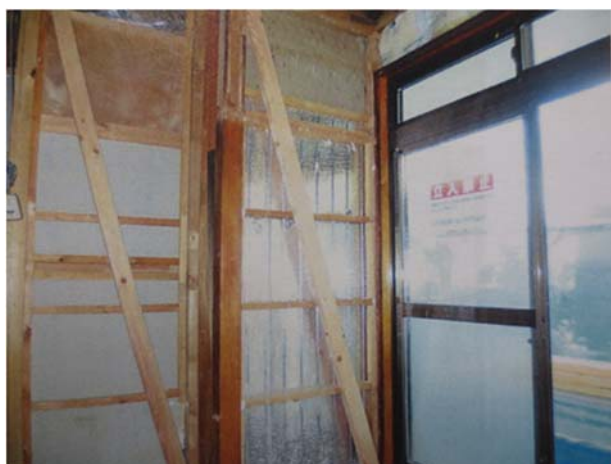
筋交い補強による耐震化工事
