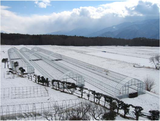
事業補助金で整備した農業ハウス
