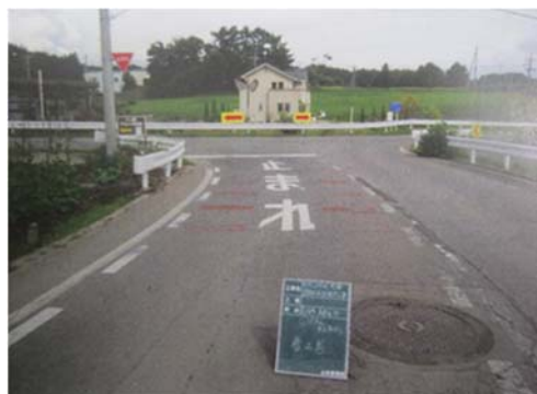
交差点カラー舗装前
