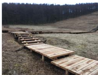
入笠地区遊歩道整備
