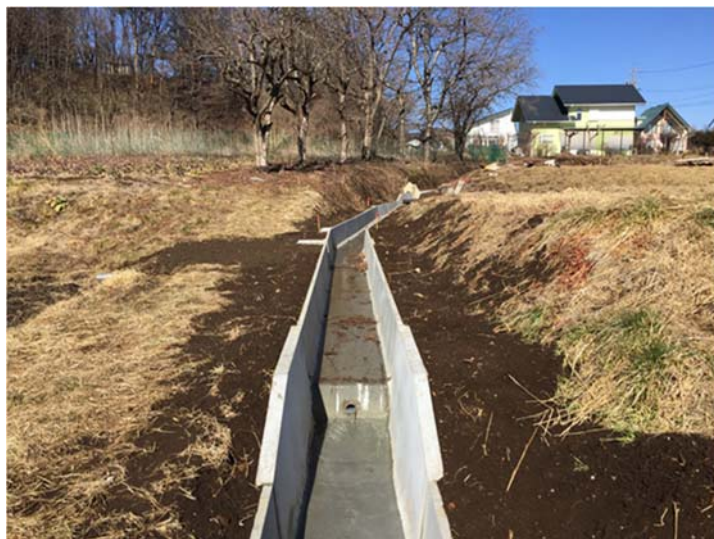
平成28年度の工事箇所
