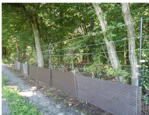
トタンと電線を組み合わせた電気柵
