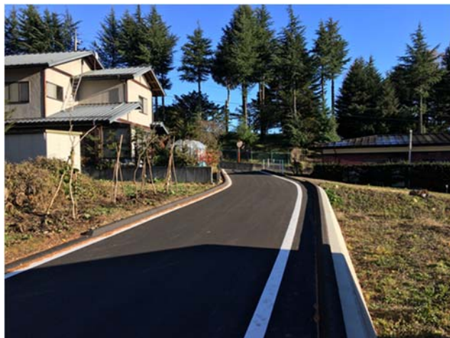
完成した区内道路
