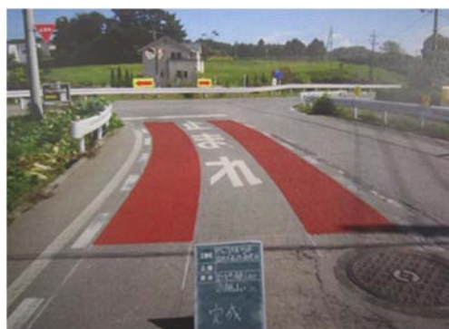
交差点カラー舗装後
