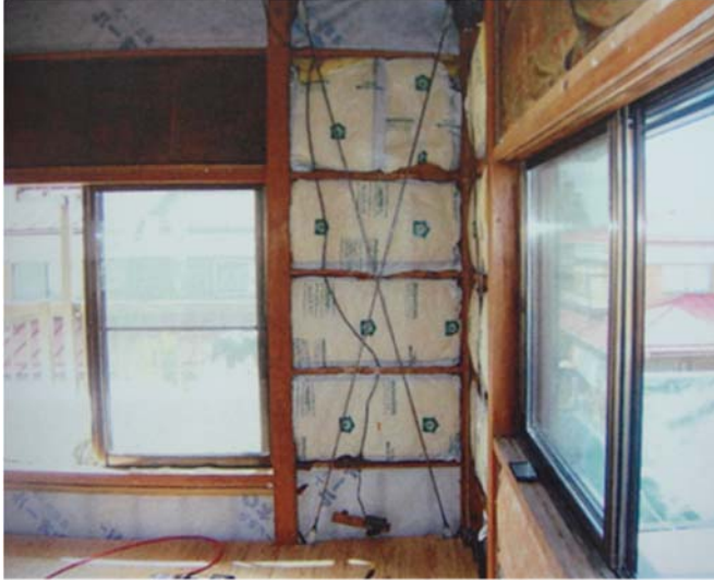
耐震補強金具の施工
