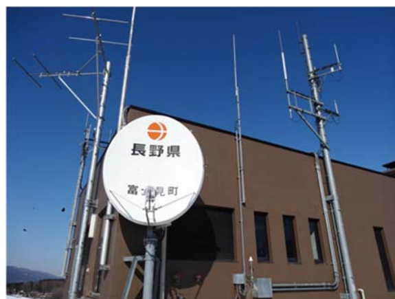
取替が予定されている県衛星系防災行政無線
