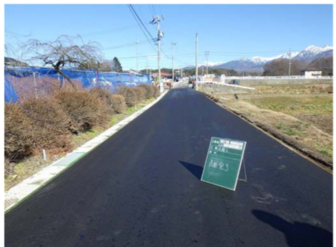
完成した区内道路
