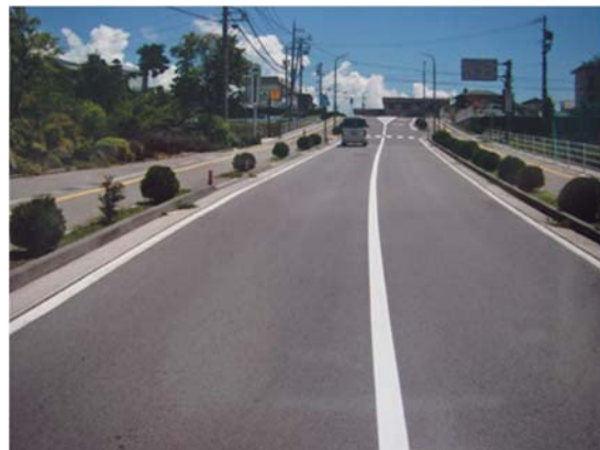
道路標示の補修
