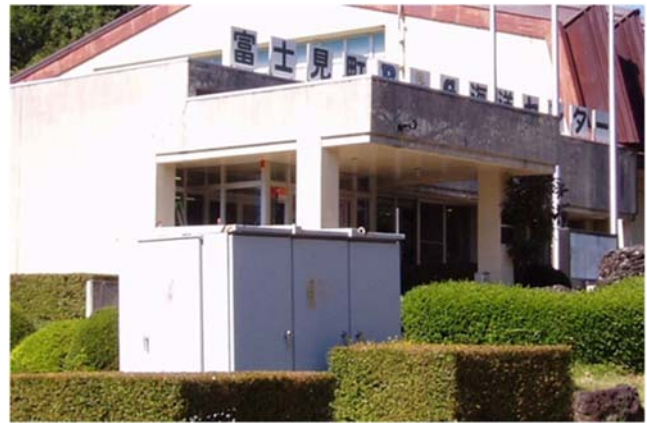
高圧変電設備（海洋センター前）
