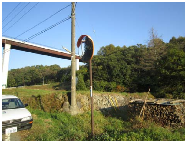
カーブミラーの設置
