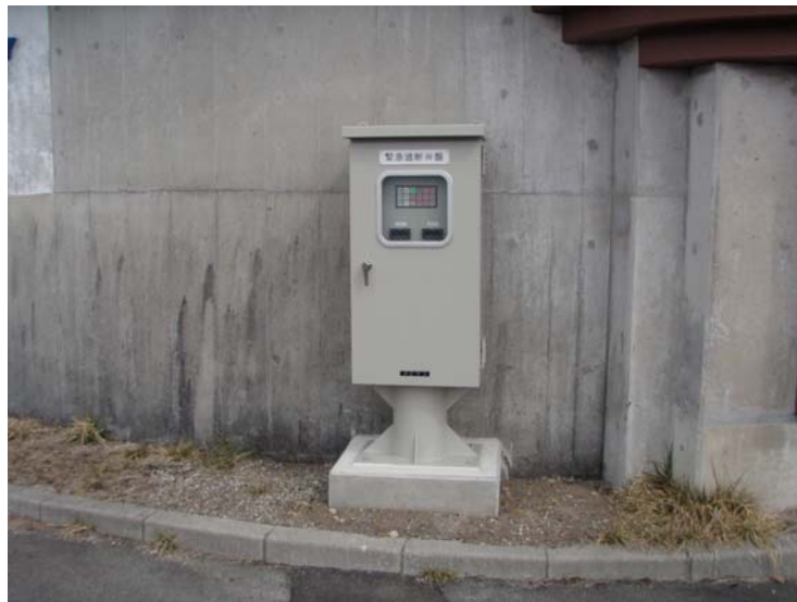
八ヶ岳第三配水池緊急遮断弁設置工事
