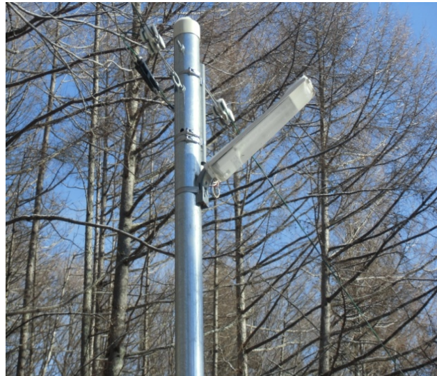
新設されたLED型防犯灯
