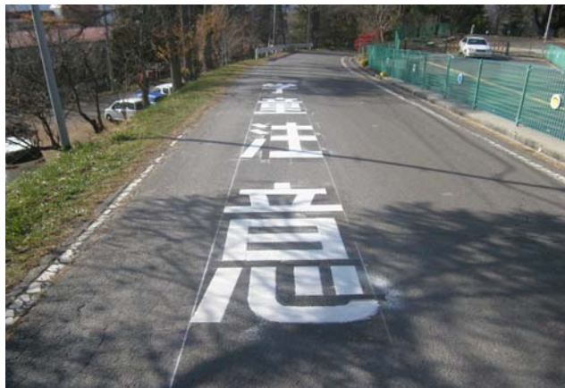
道路標識の補修
