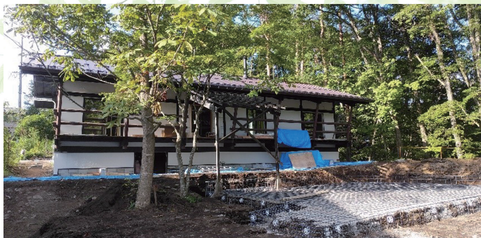
▲森のオフィスLiving 外観 (改修工事中)
