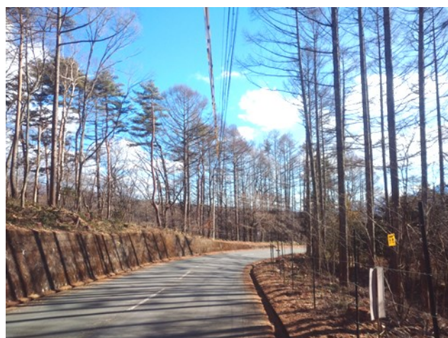
主要道路沿い等の危険木対策を実施
