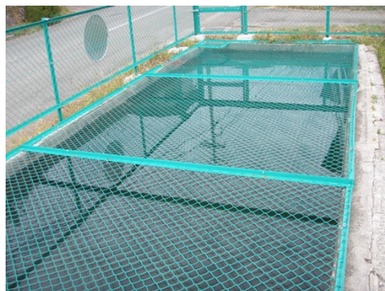
葛窪区 防火貯水槽のネットフェンス改修
