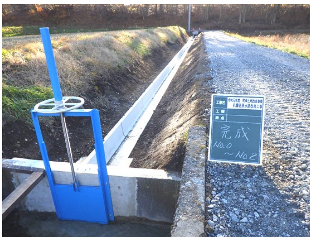
完成した用水路工事
