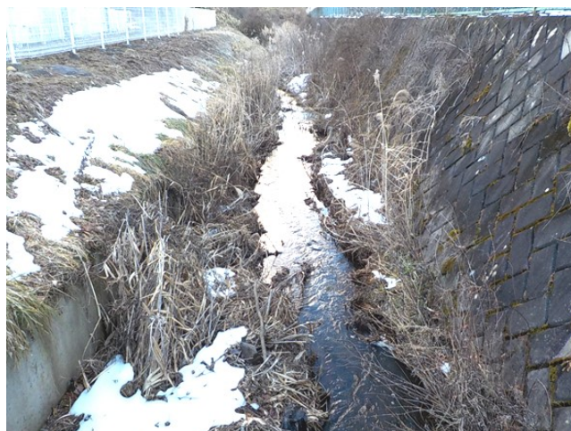
河川の堆積土砂等の状況
