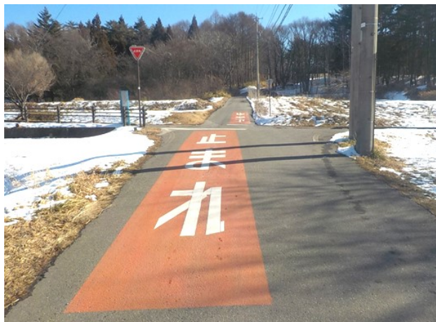
整備された道路標示
