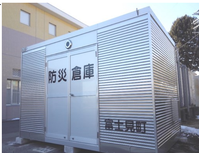
令和元年度にコミュニティ・プラザ へ設置した防災倉庫
