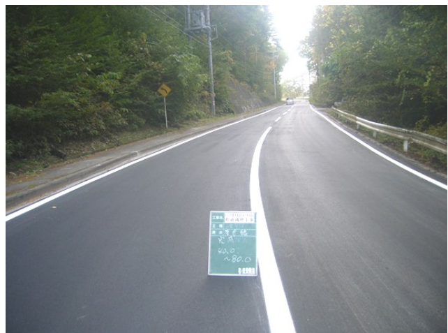
令和元年度舗装改修工事箇所
