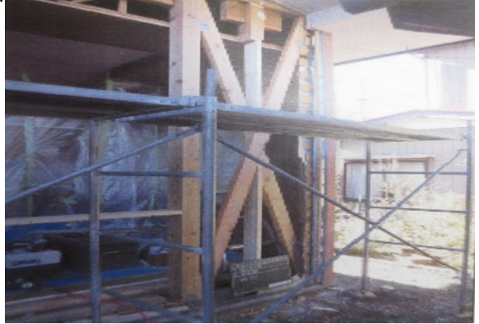
筋交い補強による耐震化工事
