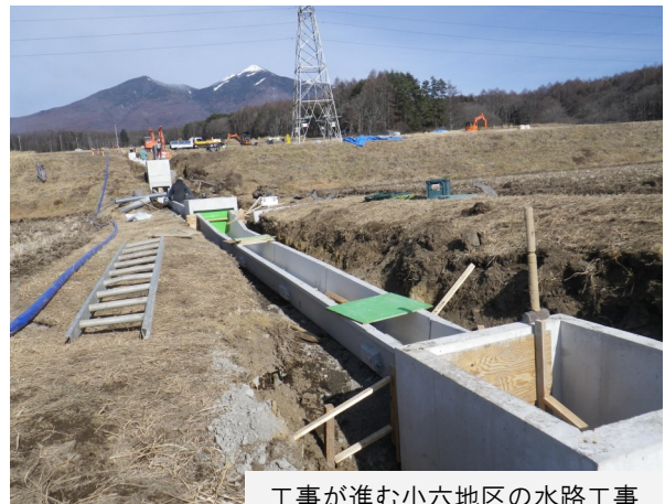
工事が進む小六地区の水路工事
