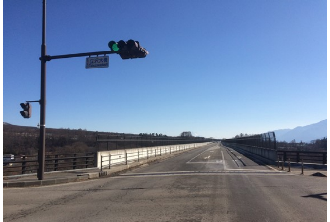
ハケ岳エコライン立沢大橋（令和3年度補修設計実施）
