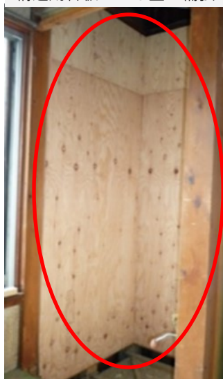
構造用合板による壁の補強
