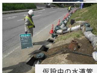
仮設中の水道管
