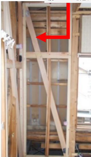
筋かいの新設
