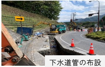
下水道管の布設
