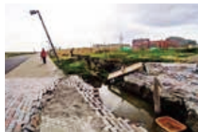
千葉県浦安市で発生した液状化現象
