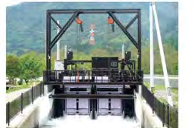
農業用水に設置されている県内の小水力発電
