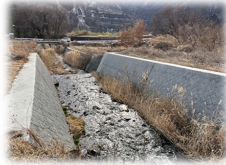
鹿之沢川工事完了箇所
