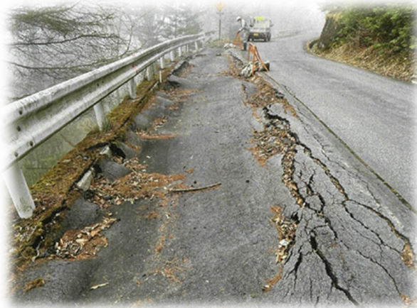
林道入笠線工事予定箇所
