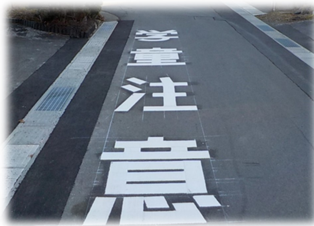
整備後の区画線
