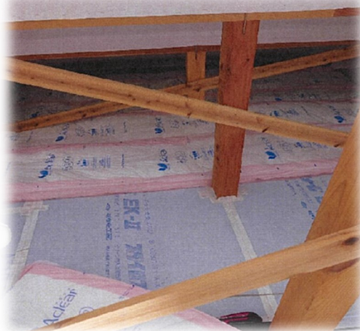
天井の断熱性を高めるリフォーム
