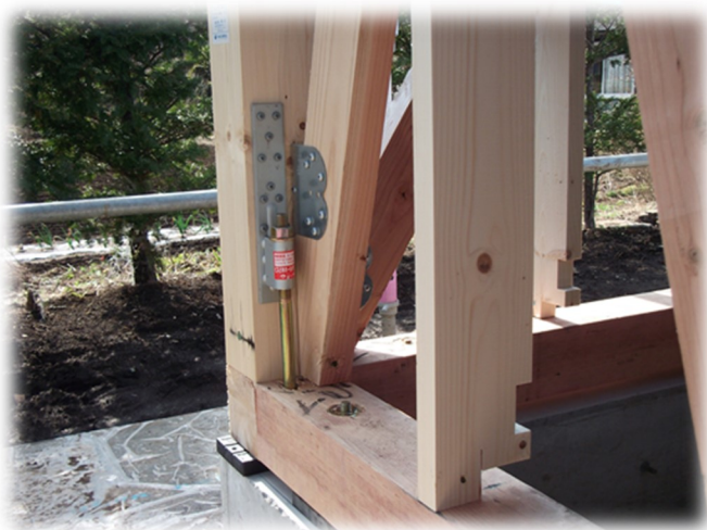
ホールダウン金物による補強
