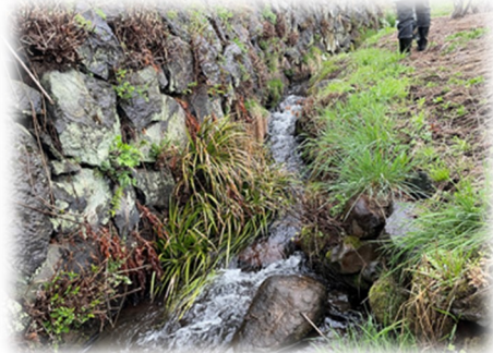
栗生田川工事予定箇所
