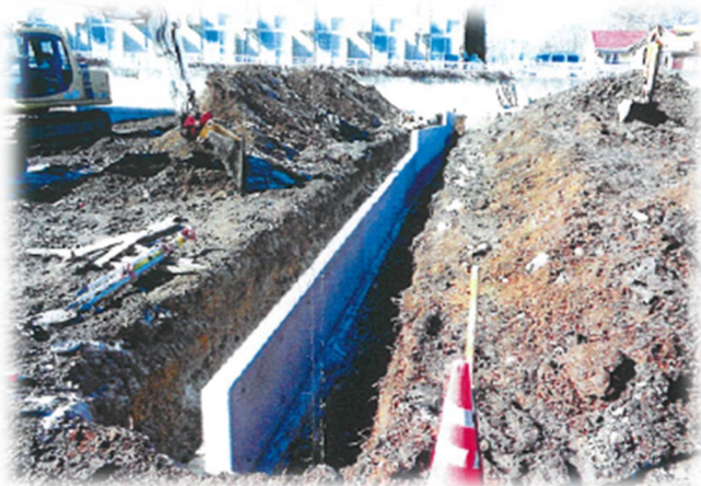
宅地造成工事
