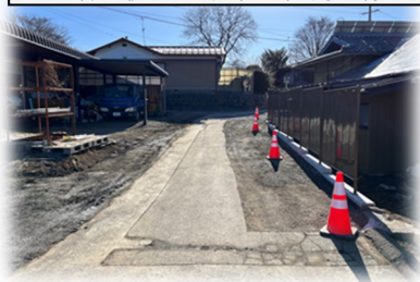
(着工後) 乙事中下組流川線
