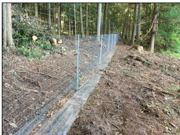
緩衝帯整備（樹木伐採と草刈り）
