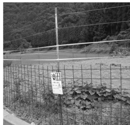
図 7-1 通電式支柱「おじろ用心棒」を用いた電気柵の構造（巻末資料①）
