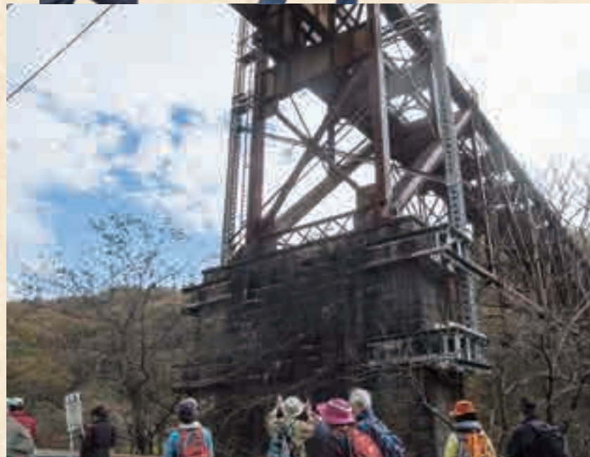
映画『風立ちぬ』にも登場する旧立場川橋梁の迫力に圧倒される。
