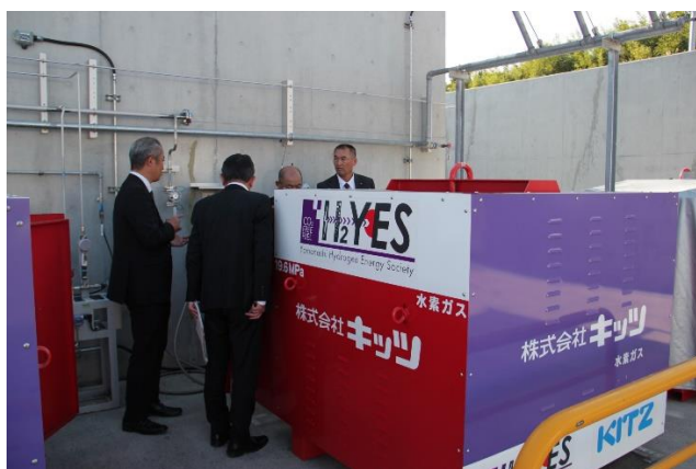
圧縮された水素はパッケージ化(赤タンク:50 m 3 )され、トレーラー(2,700 m 3 )へ。
