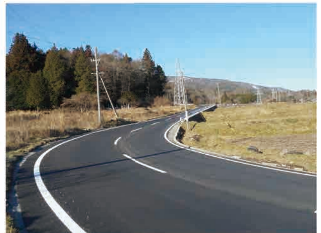
道路の補修舗装が完成した休戸、花場線
