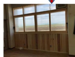
この部分だけ壁断熱
