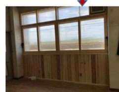
この部分だけ壁断熱
