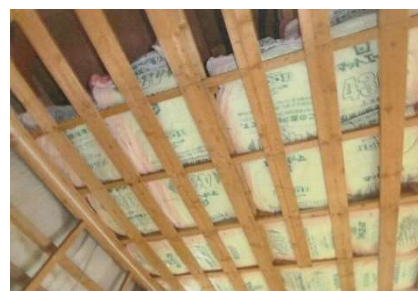
天井の断熱性を高めるリフォーム
