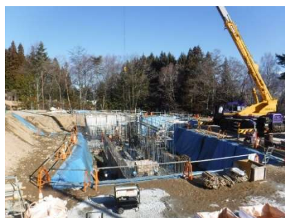
第6水源膜ろ過方式浄水場工事の様子
