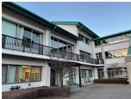
改修後の富士見中学校北校舎(令和5年度実施)
