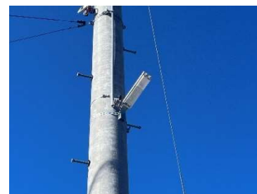
防犯灯の設置
