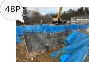
上下水道整備
