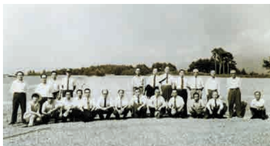
▲富士見台住宅団地造成竣工記念 昭和 45年 9月 7日
