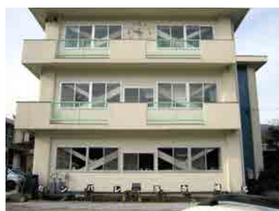
小・中学校耐震工事了 （写真は落合小学校）
