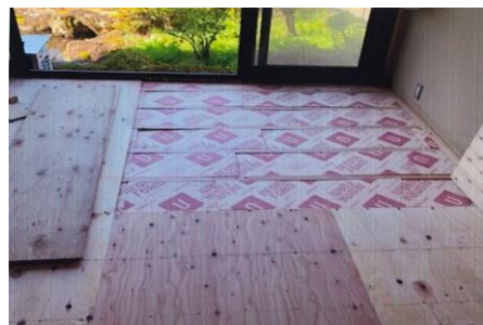
床下の断熱材工事
