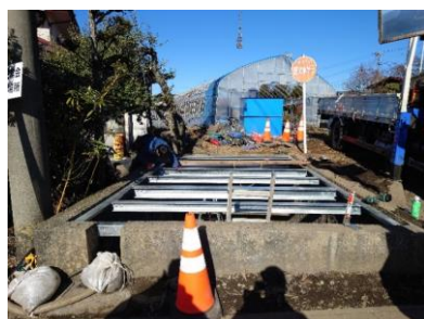
防火貯水槽修繕工事
