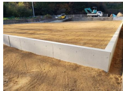
区画造成工事後の様子
