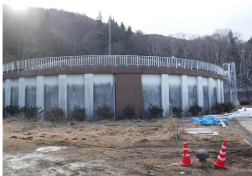
富士見第2配水池
