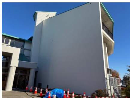
外壁改修後の様子
