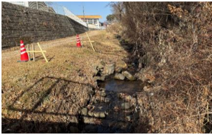
ブロック積みにより護岸を強化します
