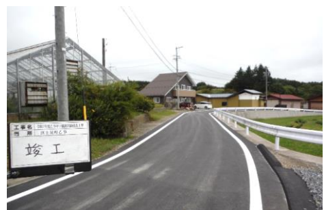
令和7年度に全線が工事完了した 乙事中下組流川線
