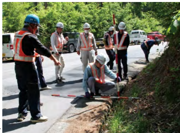
側溝の具合を調査している様子▶
