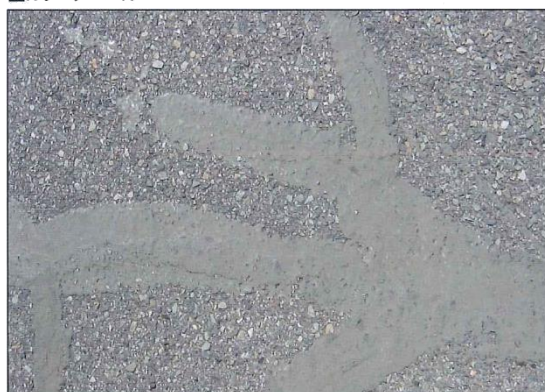
写真-6.3 カラー系のクラックシーリングと一般のクラックシーリング施工後
