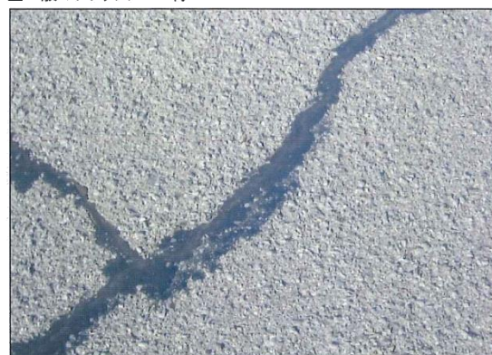
写真-6.3 カラー系のクラックシーリングと一般のクラックシーリング施工後
