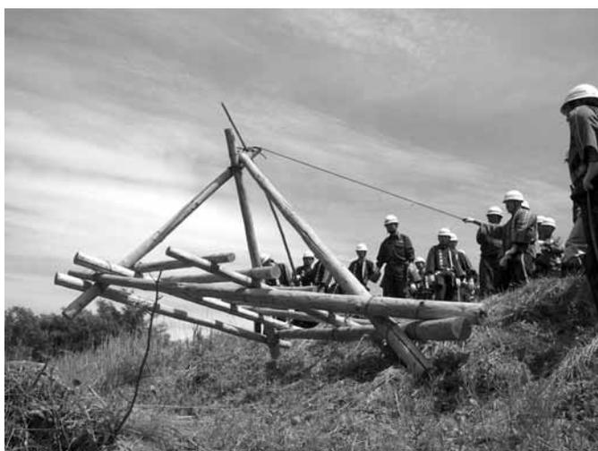
牛柵は、豪雨等により増水した河川の流れを安全な方向に変えるための工法（道具）ですが、激流の中での設置は大変危険な作業です。（昔は命綱をつけて行なっていました。）
