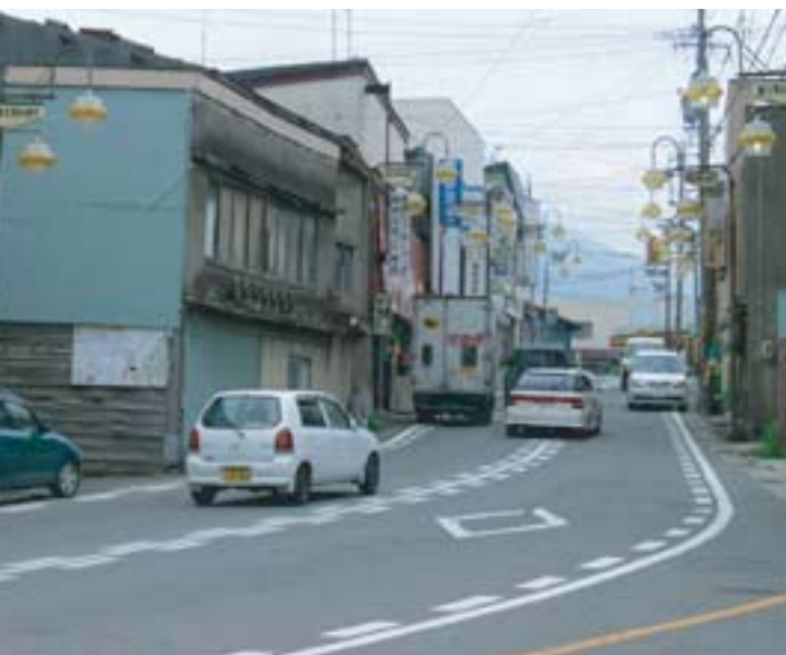
老朽化が目立つ「商店街の街路灯」
