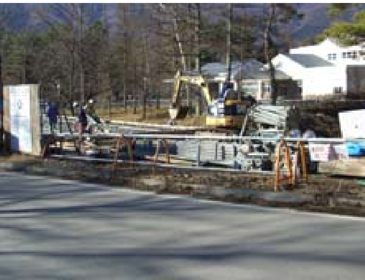
紅林荘隣に建設中の「グループホームやまゆり」
