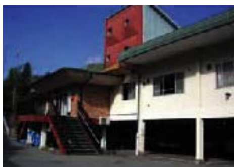
本年度耐震診断を実施する富士見区役所
